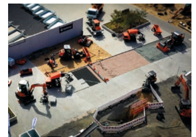
Optimas Musterbaustelle im Coreum, Stockstadt a. R.
